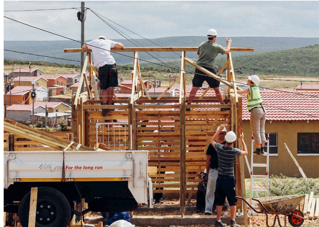
Ausrichten der Dachbinder
