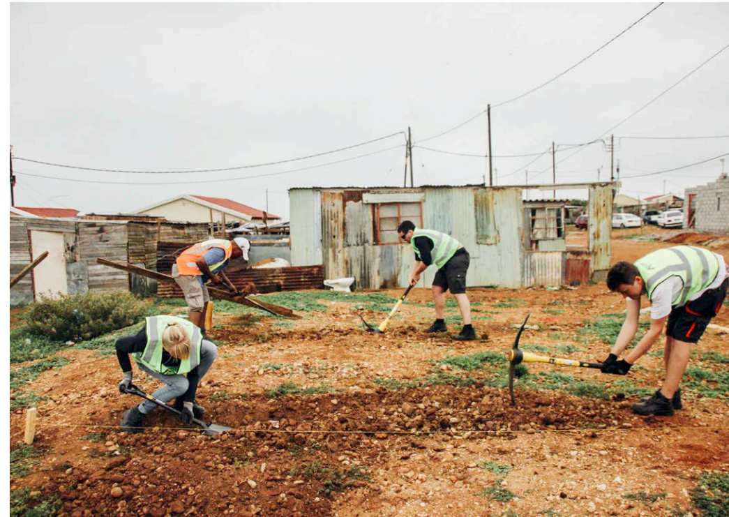
Herstellung der Fundamentgräben
