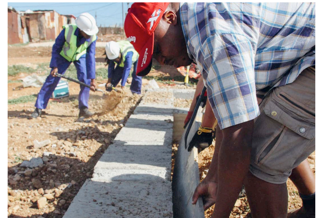
Ausschalen und Verfüllen
