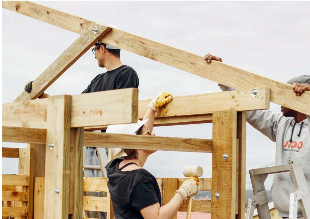
Montage der Dachbinder
