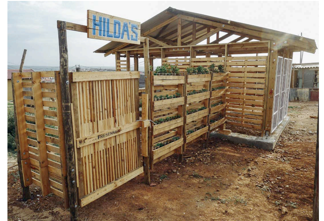
Die fertiggestellte Erweiterung
