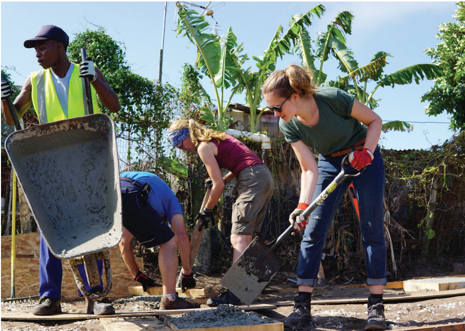
Gemeinsames Betonieren der Punktfundamente
