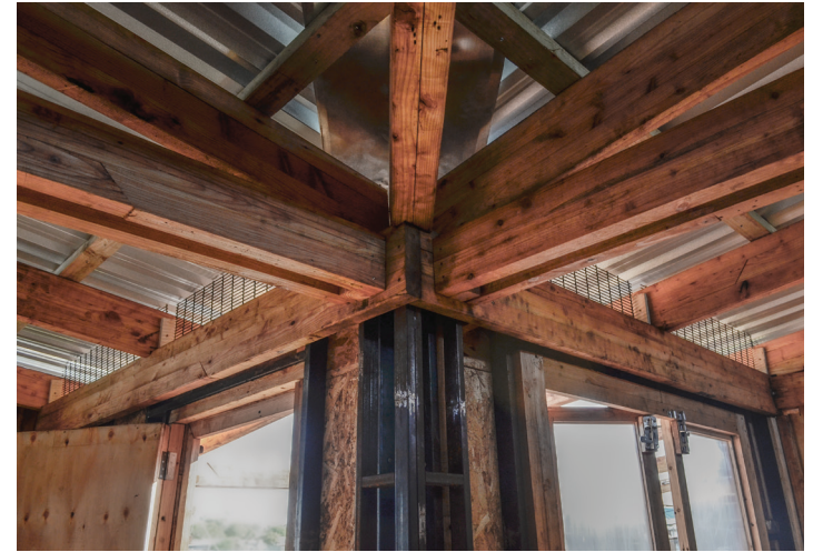
Knotenpunkt der Dachkonstruktion
