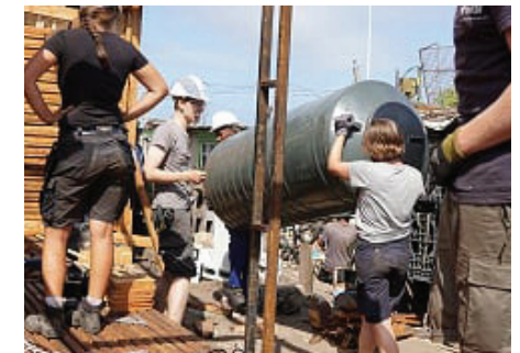
Installation des Regenwassertanks
