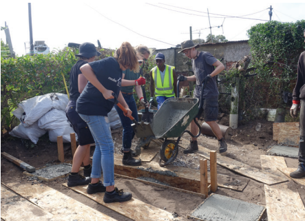
Betonierarbeiten Foto: F. Nessler
