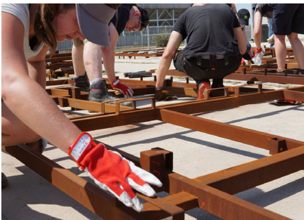
Lackierarbeiten Foto: M. Gedamke
