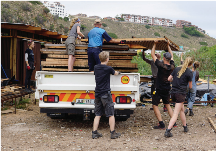
Verladen der vorgefertigten Außenwände
