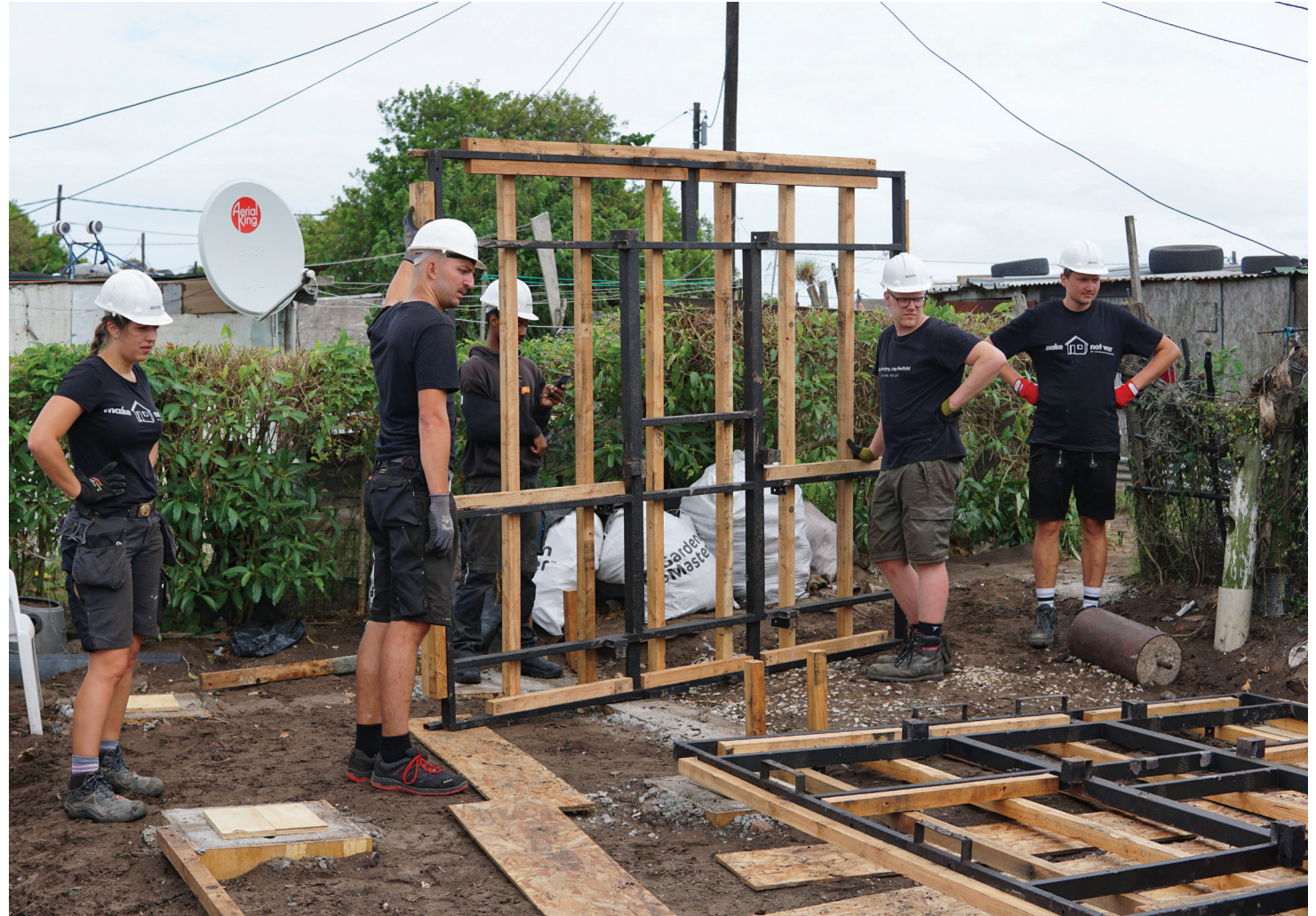
Einbringen der Metallrahmen als Bodenunterkonstruktion
