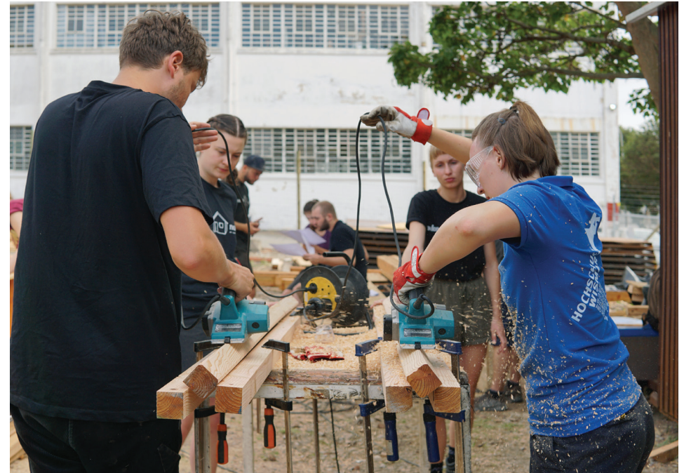
Vorbereitung des Gehbelags
