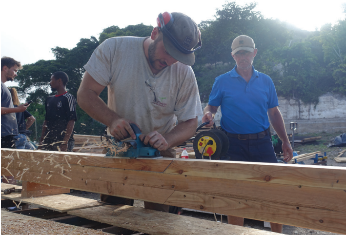
Nachbearbeitung der Dachsparren
