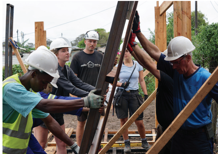
Einbau der Außenwände
