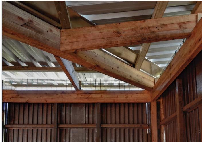
Anschlüsse der Dachkonstruktion an die Außenwände
