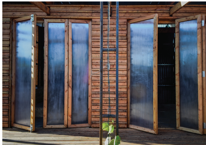
Fassade mit großflächigen Türöffnungen
