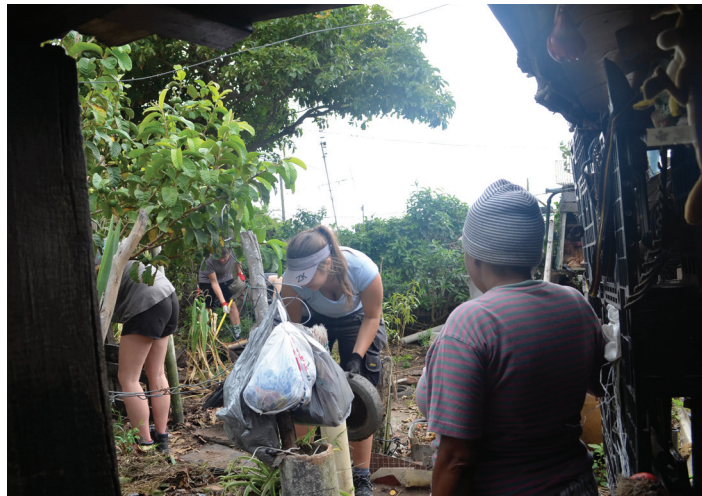
Aufräumarbeiten auf der Bafläche
