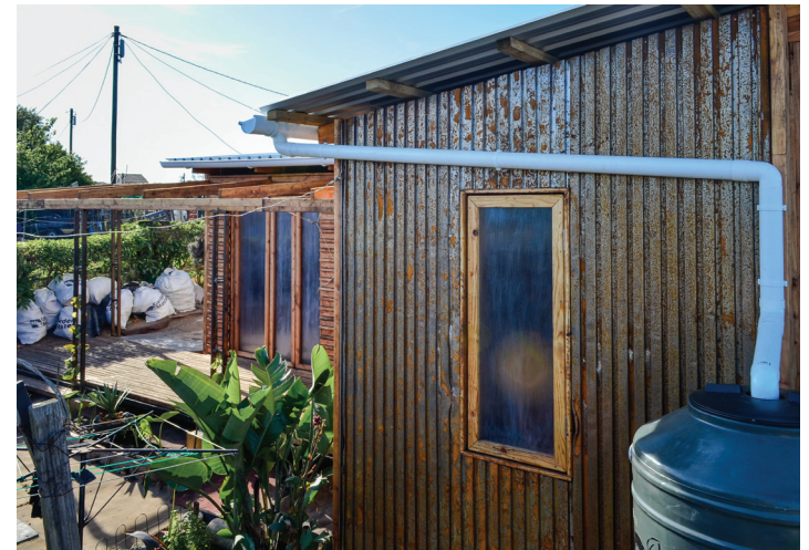
Dachentwässerung mit Wassertank zur Gartenbewässerung
