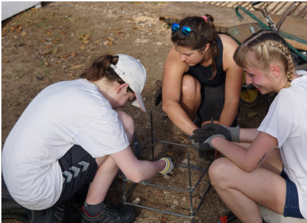
Bewehrungskörbe Foto: L. Güntsche
