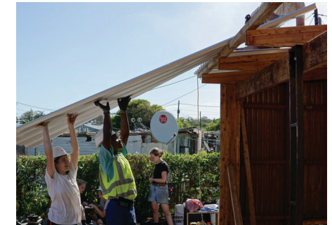
Platzieren der Dachdeckung
